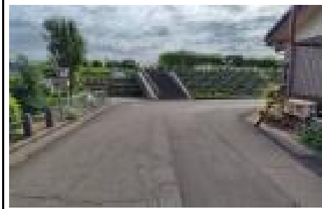
②パンダ公園の角・ラピス側(見通しが悪く危険、堤防に通じる側道も自転車の交通量が多いが、木で分かりづらい)
