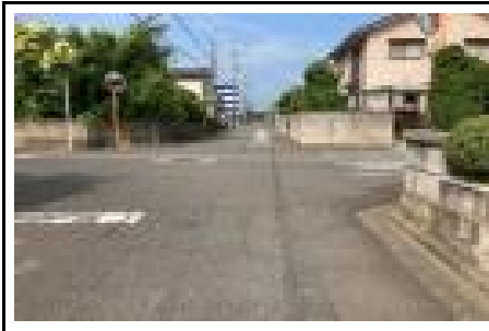
②横断歩道はあるが、ブロック塀があって見通しが悪い。
